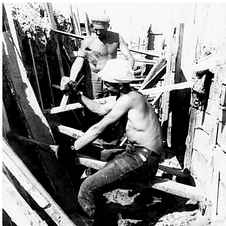
Студенческий стройотряд. Подготовка опалубки для заливки фундамента школы, Казахстан, п. Фурманово, 1968 г.
